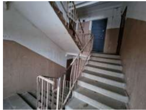
4.stāva kāpņu telpa
